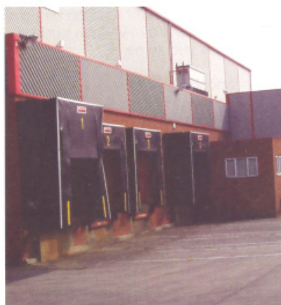
Figura 2: Rampe separate pentru recepție și expediere, dar în ambele cazuri transferul produselor trebuie să fie rapid și protejat pentru a reduce expunerea la temperaturi înalte și contaminări.
