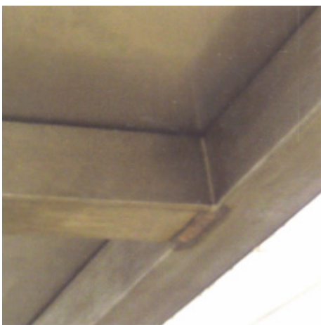
Fig. 14: Pe de altă parte, tabla pe care sunt construite lăzile din tubulatură cu toate încheieturile sudate, ceea ce face să reducă suprafețele unde se poate acumula mizeria.
