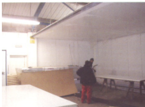
Fig. 8: Folosirea panourilor de PVC pentru a forma pereți igienici și tavane false în timpul construcției zonei de lucru. O altă structură furnizează ambele structuri de suport și bariere suplimentare contra contaminării și dăunătorilor.
